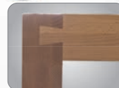
Schwalbenschwanzverzinkung in Hinterzange und Beiladerücken
